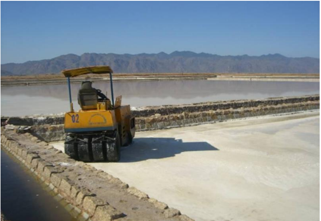
Hình 5. Lăn ép mặt ruộng muối
